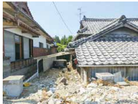
令和7年8月豪雨災害 熊本県八代市の被災の様子
